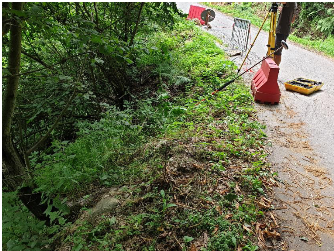
Figura 2: Vista 2 verso sud-ovest dell'area d'intervento.
